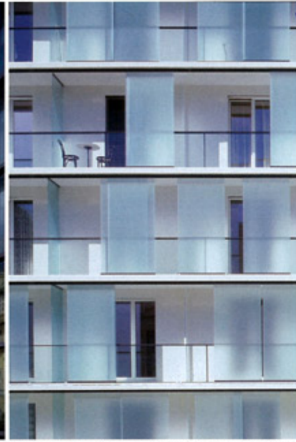
建筑物前方配置透明和不透明玻璃，使阿舒兰格特的住户隐私得到保护。
